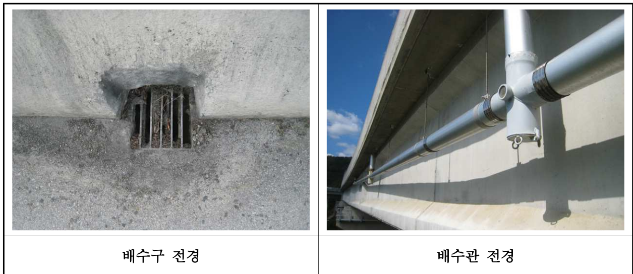
【사진 14.3.21】 배수시설 전경
