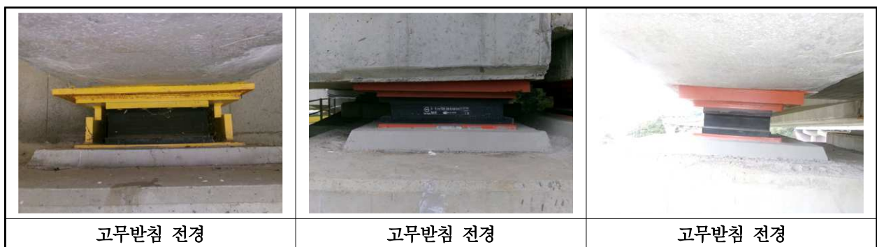
【사진 14.3.12】 교량반침 전경
