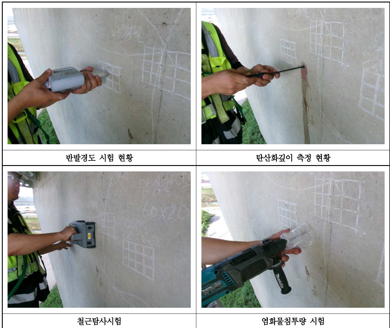
【사진 14.4.1】 콘크리트 내구성조사 현황
