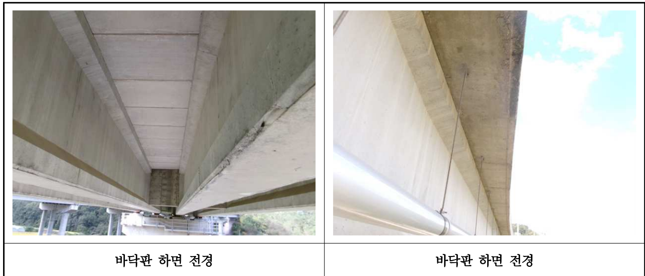
【사진 14.3.2】바닥판하면 전경
