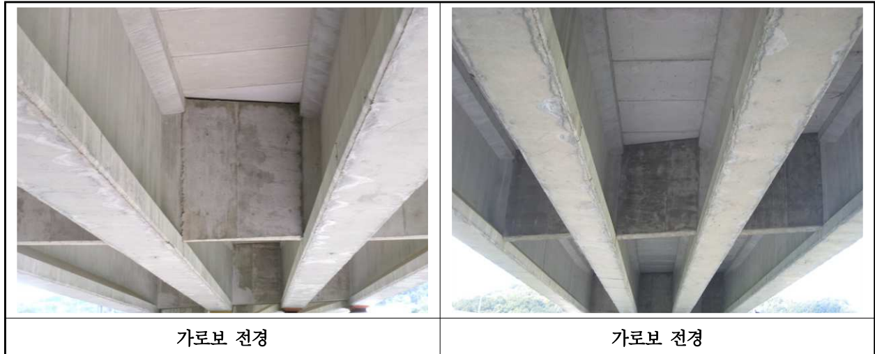
【사진 14.3.6】 가로보 전경
