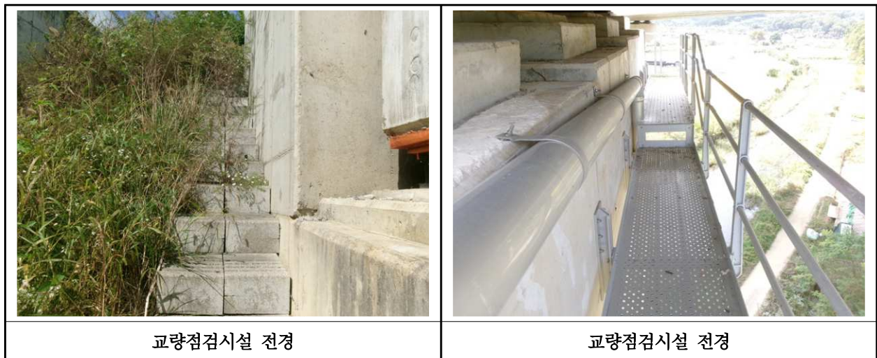
【사진 14.3.25】 교량 점검시설 전경
