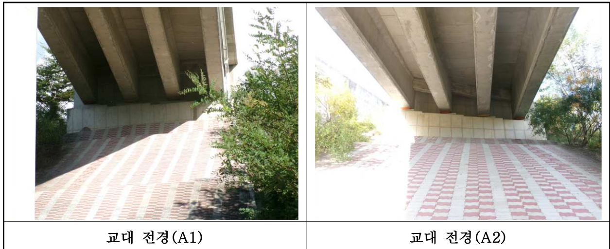
【사진 14.3.8】 교대 전경
