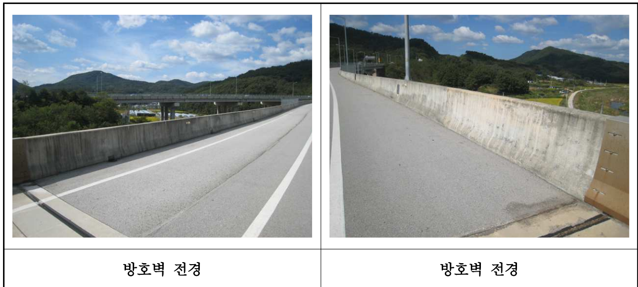
【사진 14.3.23】 방호벽 및 중앙분리대 전경
